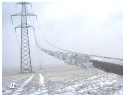
Рисунок 2 а,б Характерное обледенение проводов с круглой проволокой
