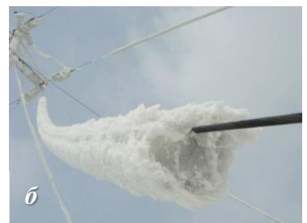
Рисунок 2 а,б Характерное обледенение проводов с круглой проволокой
